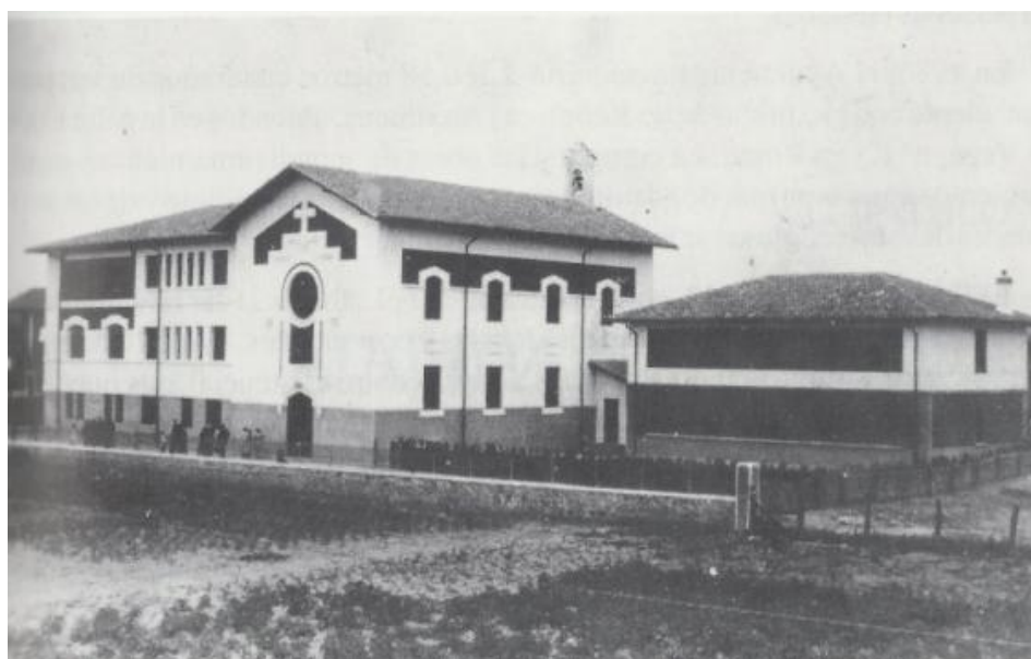
Escuelas y Capilla vistas desde el sur
